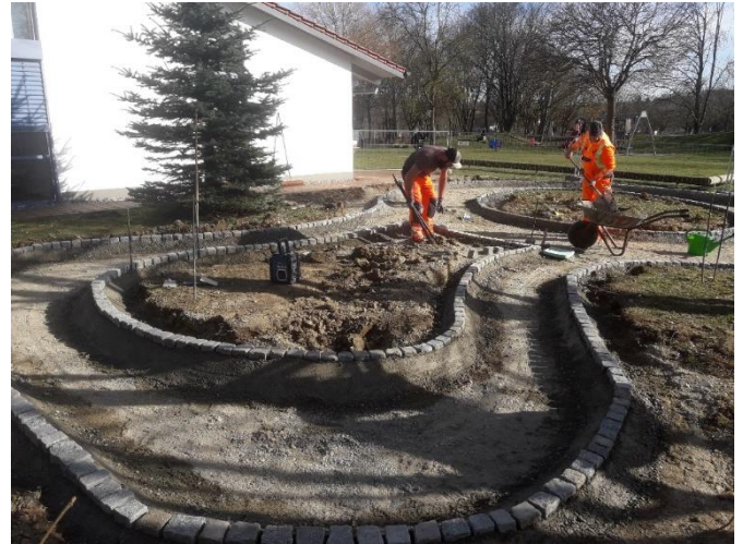
Bauhofmitarbeiter beim Bau!
