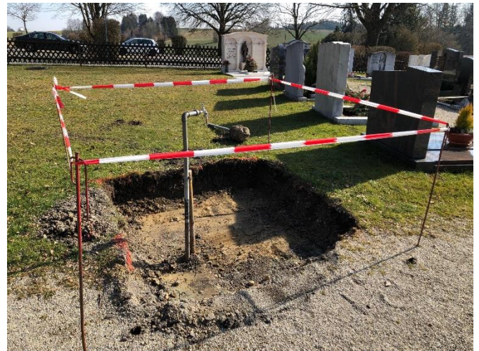
Als weitere Maßnahme werden die Bereiche für die Gießwasserstellen gepflastert - mit ausgebauten Granitsteinen vom Stadtplatz.
