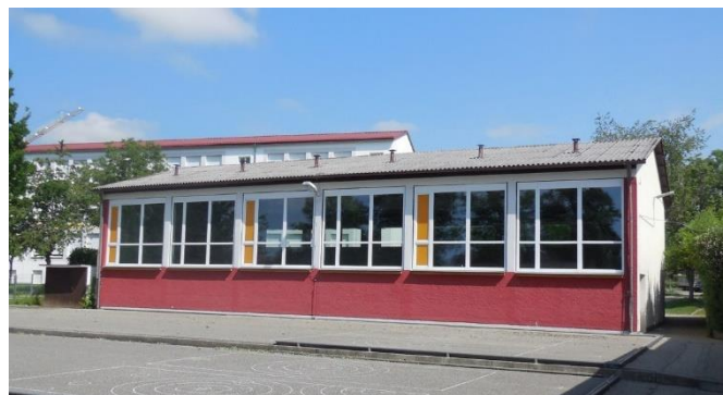
Alte Turnhalle – vor der Sanierung (Foto: Stadt)
